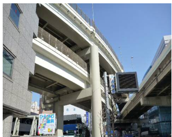
(施工後) 鋼桁・橋脚の塗装
