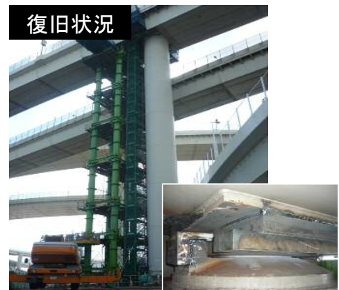
橋桁をバントで支持し、支承を補修
