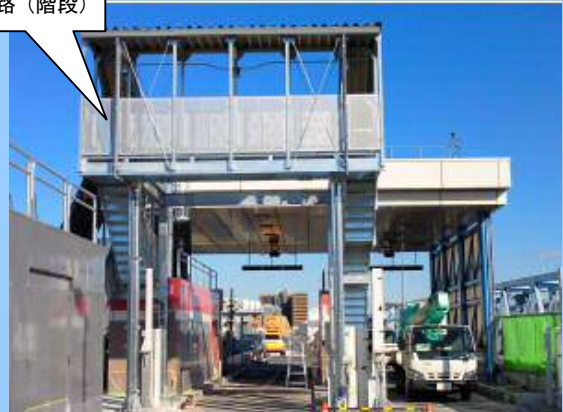
【写真】 清新町料金所における安全通路の整備
