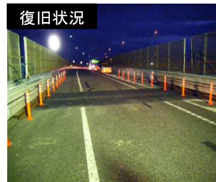
段差修正、ジョイント・舗装補修
