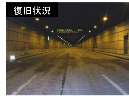
トンネル継目の漏水補修
