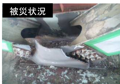
取付部材（横支材一对傾構）の損傷
