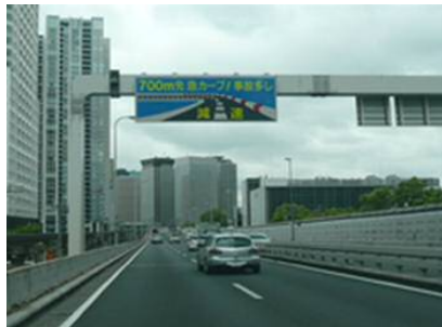
大型注意喚起板の設置
