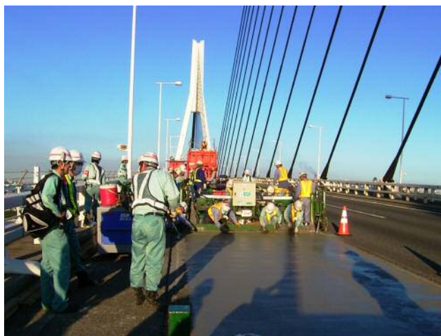
【休日 24 時間一車線規制工事実施状況（湾岸線）】
