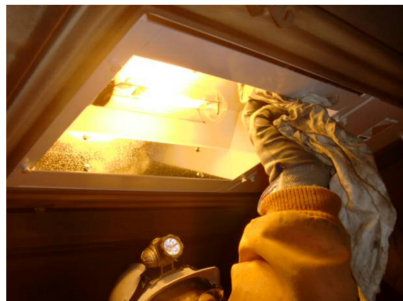
【トンネル内照明点検 （湾岸線 空港北トンネル） 平成23年2月実施】
