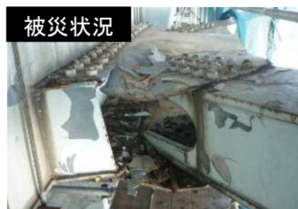
取付部材（横支材一下横構）の損傷
