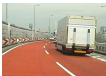
【注意喚起カラー舗装】
