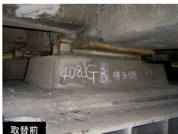
【1号横羽線子安付近におけるPC桁の支承取替】
