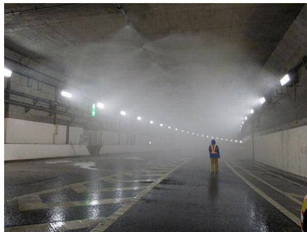
【水噴霧設備点検 （埼玉新都心線 新都心トンネル） 平成22年5月実施】
