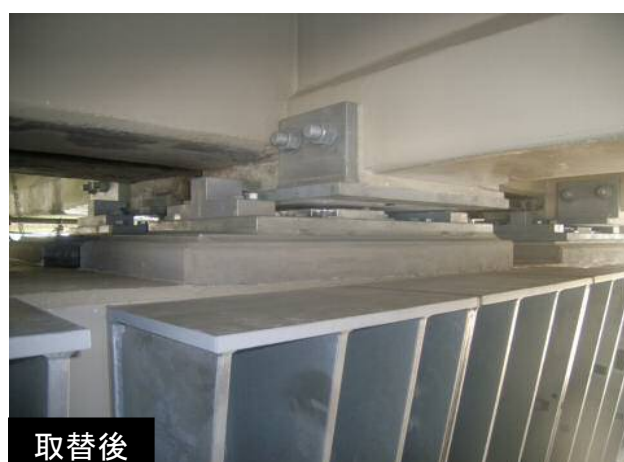
【1号横羽線子安付近におけるPC桁の支承取替】
