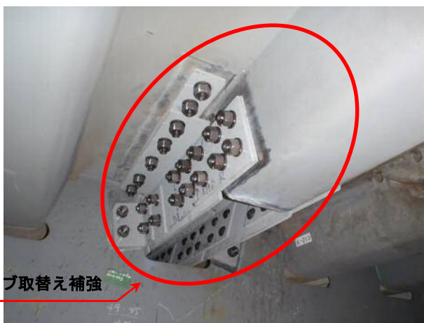
【湾岸線京浜大橋における鋼床版の補強】
