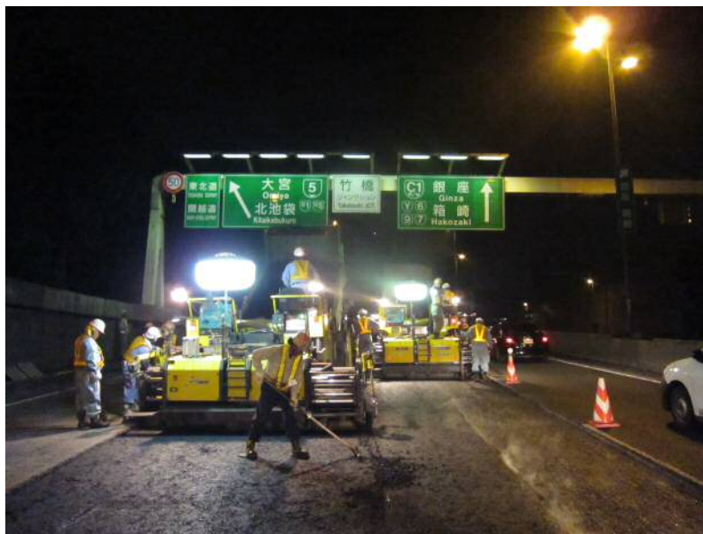
【舗装工事実施状況】
