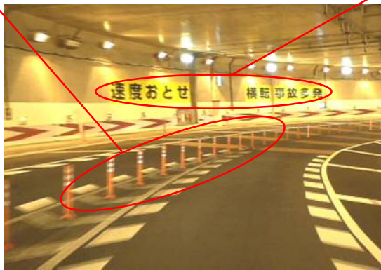
【大橋 JCT 内での更なる安全対策】
