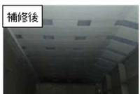
コンクリート床版の下面に炭素繊維シートを格子状に接着することで、ひび割れの開閉が拘束され、コンクリート床版の耐久性が向上します。
