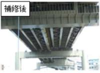
劣化した既設の塗膜を除去し、耐久性の高い塗料を用いて被覆補修を行うことで、従来よりも防食性能が向上します。
