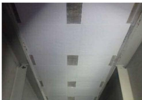
RC 床版炭素繊維補強施工状況
