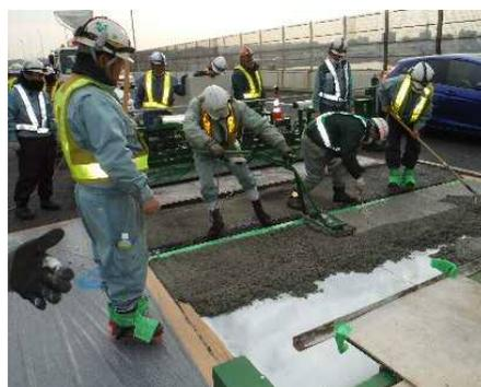
鋼床版 SFRC 舗装施工状況
