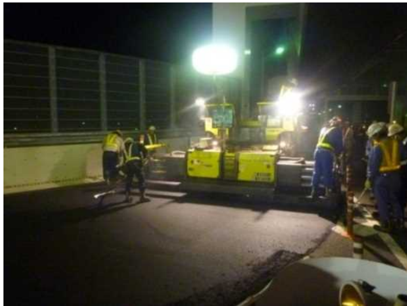
舗装工事実施状況
