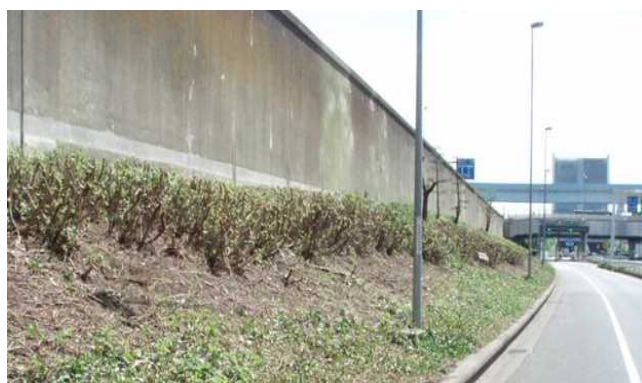
道路路肩脇の植樹の伐採後
