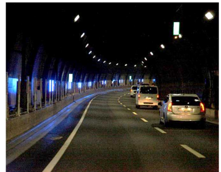
中央環状線（内回り）中野長者橋付近
