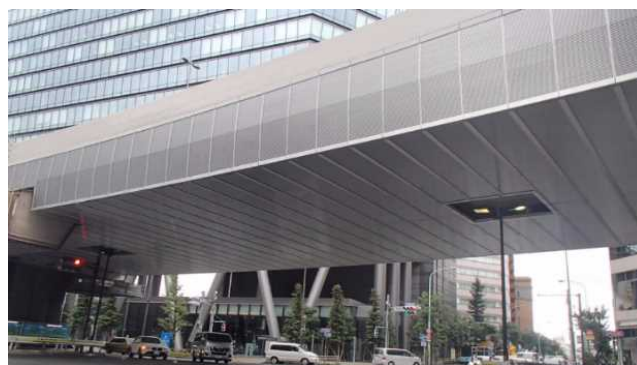
恒久足場（神泉町交差点付近）
