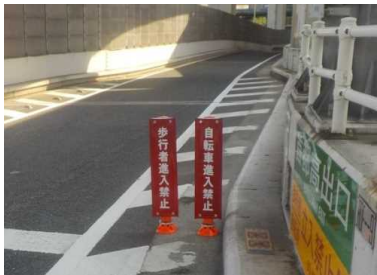
ラバーポール （堤通（下）出口）
