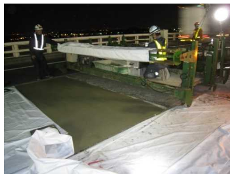
鋼床版 SFRC 施工状況
