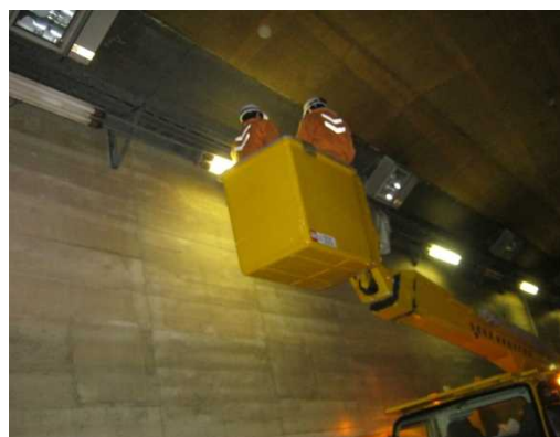
トンネル照明設備点検
