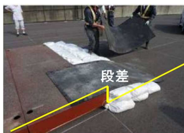
軽量土のう+ゴムマット
