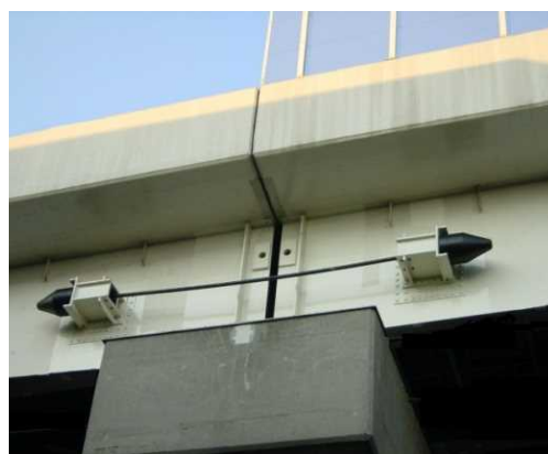
上部工の耐震補強 (落橋防止装置の設置)
