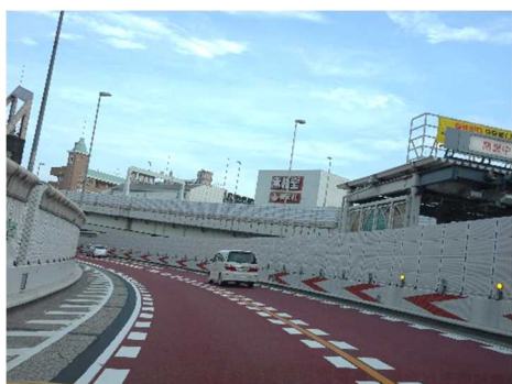
注意喚起カラー舗装
