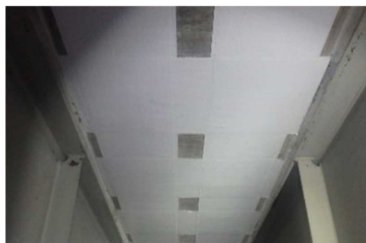
RC 床版炭素繊維補強施工状況
