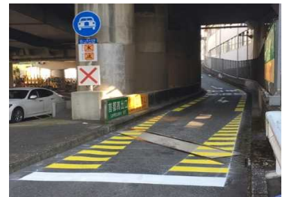
カラー路面標示 （護国寺[下]出口）
