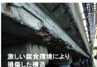
激しい腐食環境により損傷した構造
