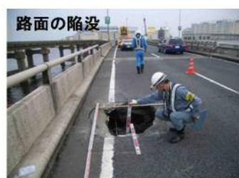
路面の陥没
