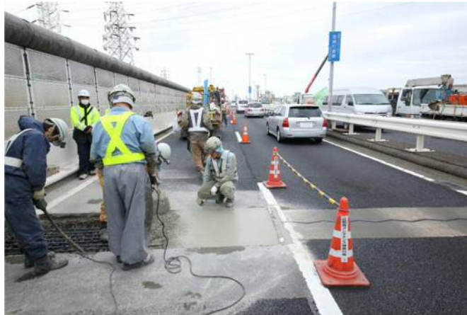
24 時間一車線規制工事実施状況（ノージョイント化工事）
