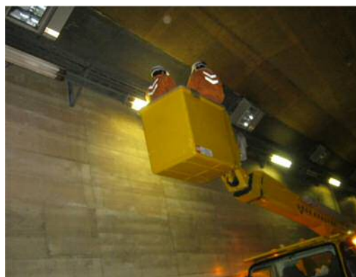
トンネル照明設備点検
