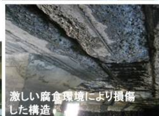
東品川栈橋・鮫洲埋立部の損傷状況
