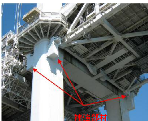
長大橋梁の耐震補強 (レインボーブリッジ主塔下路部の補強)
