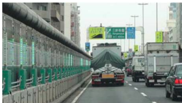
3 号渋谷線(下り)池尻～三軒茶屋付近
