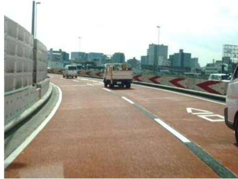
注意喚起カラー舗装
