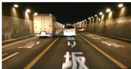
【湾岸線東京港トンネル】
