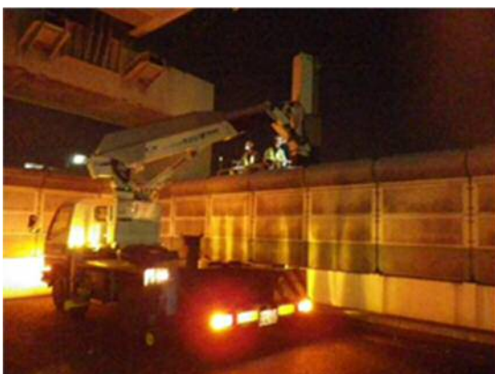
明かり部一斉点検（特殊吸音板）
