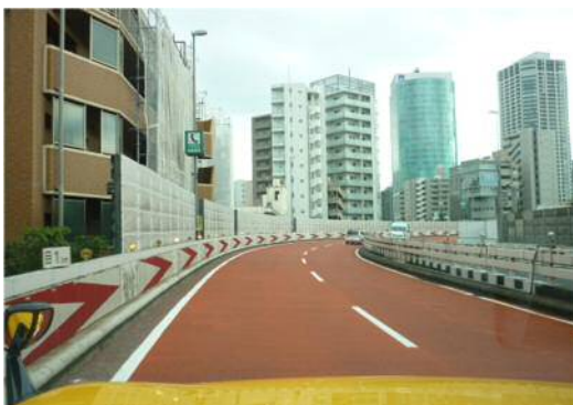
【注意喚起カラー舗装】
