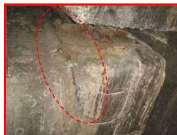
PC 桁ゲルバー部のひび割れ
