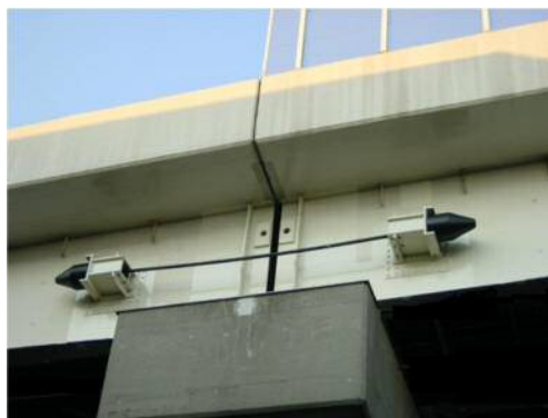
支承・連結装置耐震補強（連結装置の設置）
