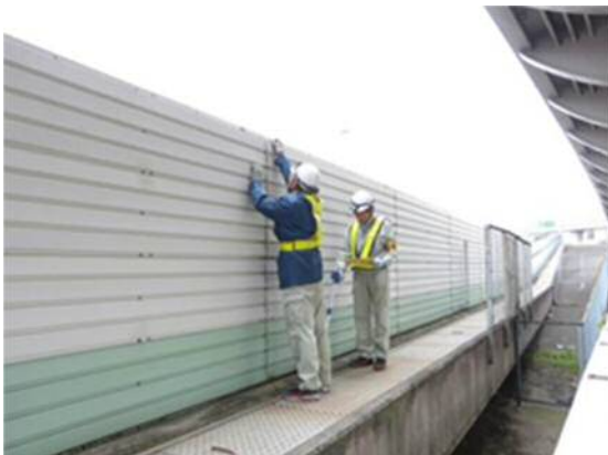
明かり部一斉点検（遮音壁外面）
