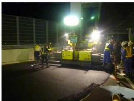
【舗装工事実施状況】
