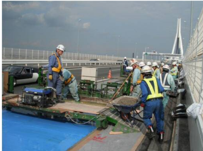
【24 時間一車線規制工事実施状況（湾岸線）】
