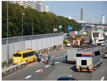
【実施状況（大井本線料金所）】
