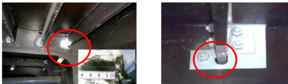
【橋梁補修工事実施状況】
