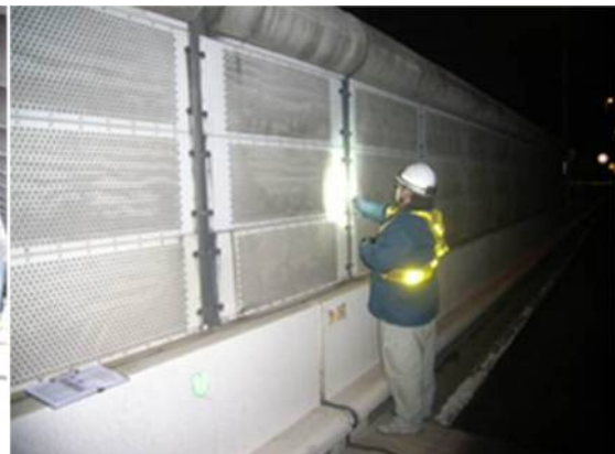
明かり部一斉点検（遮音壁内面）
