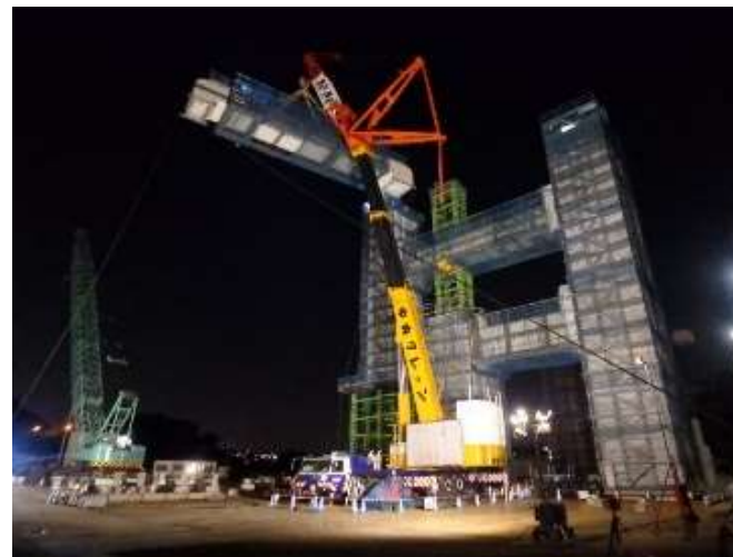
大型クレーンによる架設
