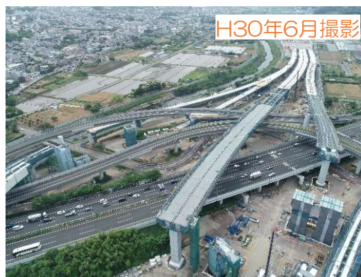
① 高架部施工状況（青葉工区）
