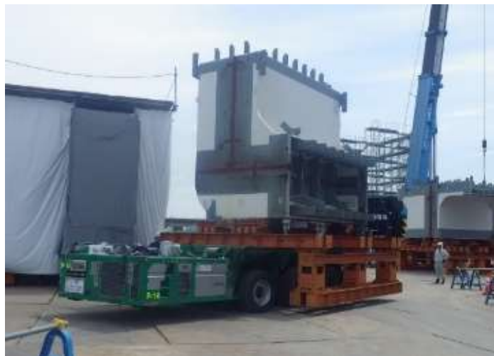
多軸台車による運搬
