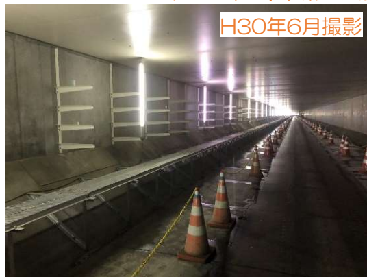
④ シールドトンネル部（床版下施設施工）
