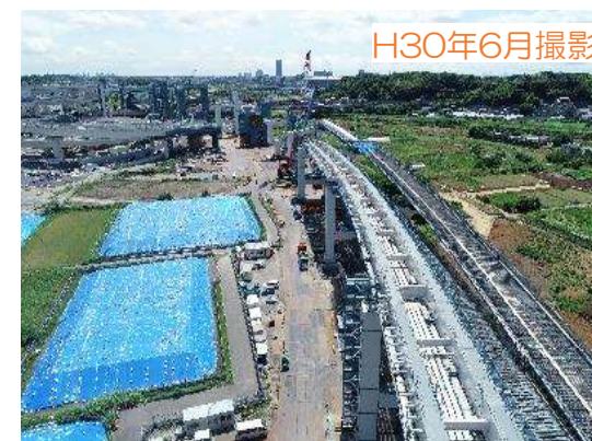
③ 高架部施工状況（港北工区）
