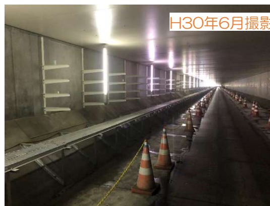
② シールドトンネル部（床版下施設施工）
