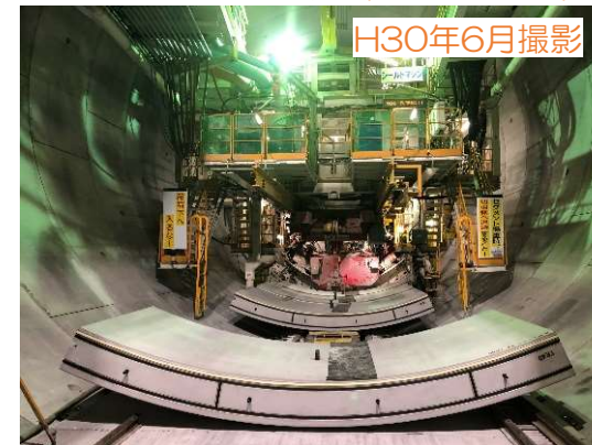
⑤ シールドトンネル部（シールド機先端）
