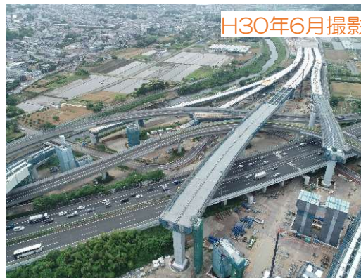
⑦ 高架部施工状況（全体）
