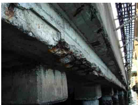
▲主桁の損傷
