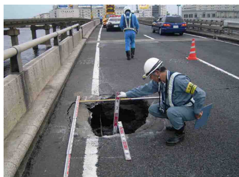
▲路面の陥没（平成20年6月発生）
