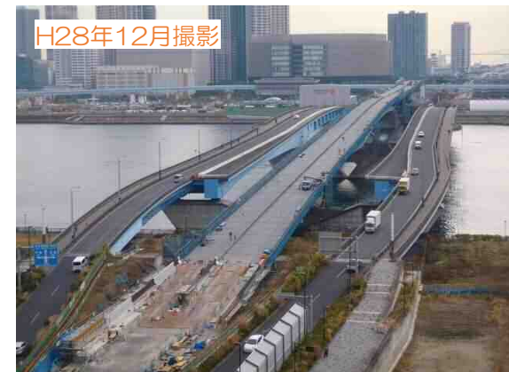
② 桁架設完了（晴海運河部）
