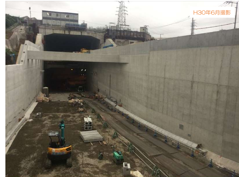
ランプ躯体構築工
