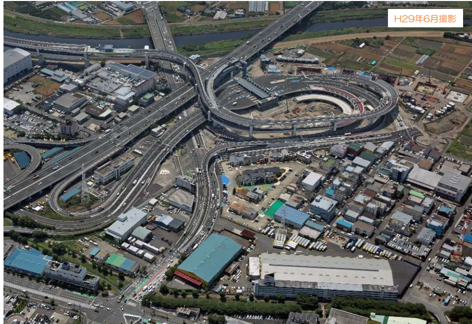
① 横浜港北ジャンクション部の完了後状況
