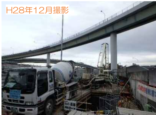
④ 青葉JCT部基礎コンクリート打設状況
