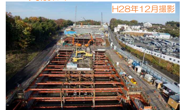
③ 東方換気所(仮称)・立坑工事・開削トンネル
