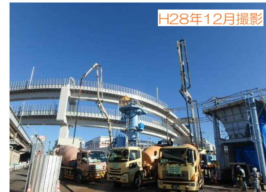
⑨ 港北JCT部への基礎施工状況
