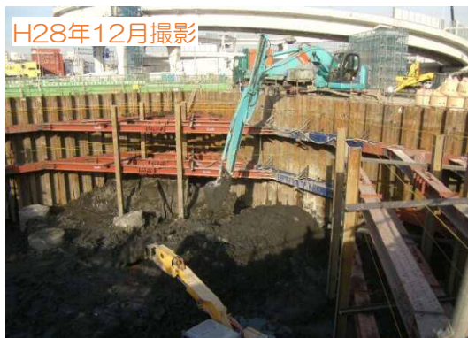
⑦ 本線高架部基礎掘削状況
