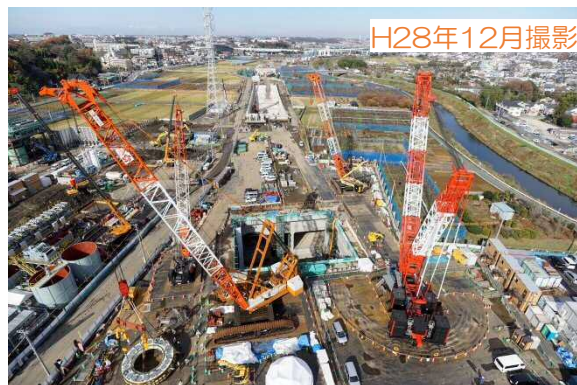
① 北八朔地区開削トンネル・発進立坑
