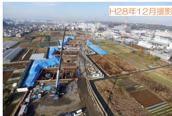
⑧ 高架部施工状況（全体）
