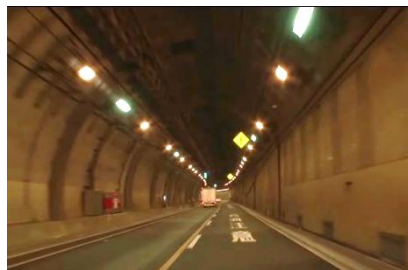
②山手トンネル(シールド区間)
