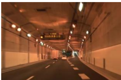
①山手トンネル(開削区間)
