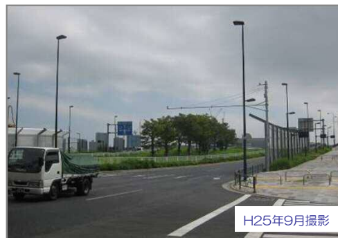
▲ 整備中区間 (晴海出入口付近)
