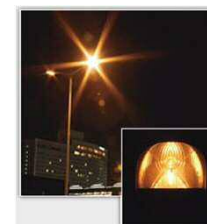
【従来の照明】 (高圧ナトリウム照明)
