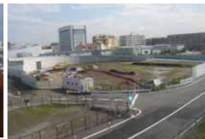
ループランプ施工状況（写真4）
