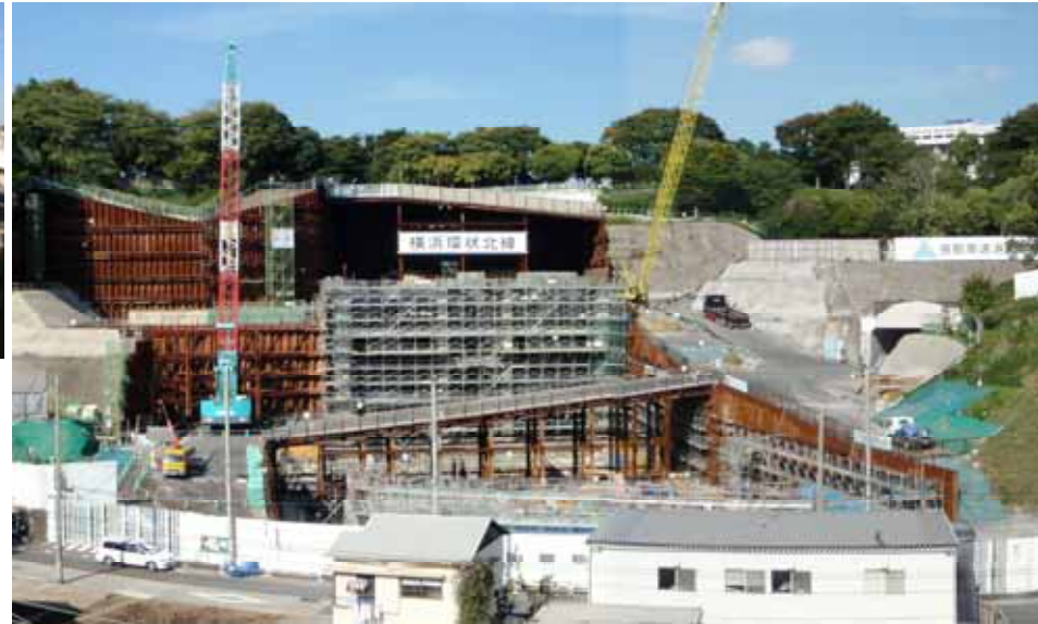
子安台換気所工事 施工状況
