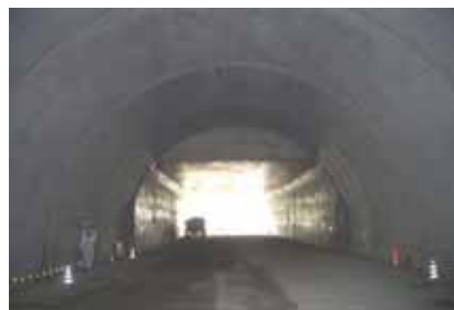
生麦方向行きトンネル内施工状況（写真2）
