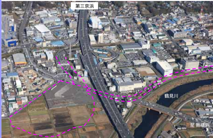
港北ジャンクション部の状況
