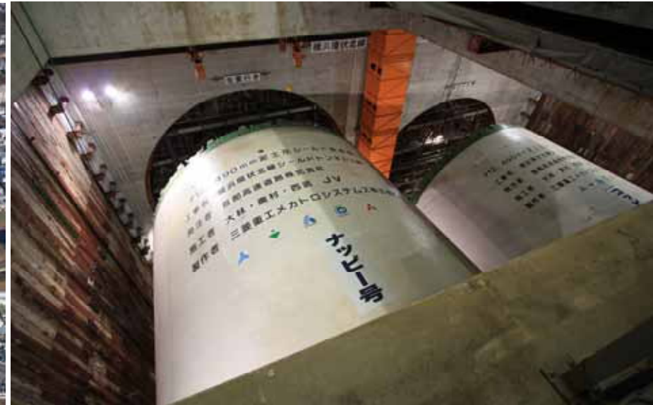
新横浜立坑部 施工状況 ( シールドマシン組立完了 )
