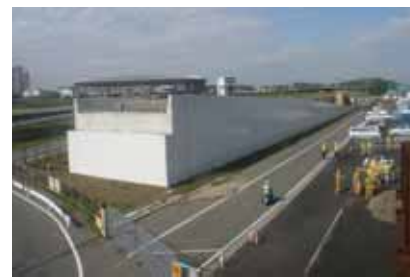
センターランプ施工状況（写真3）
