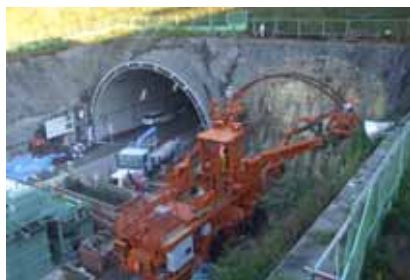
坑口付近施工状況（写真1）
