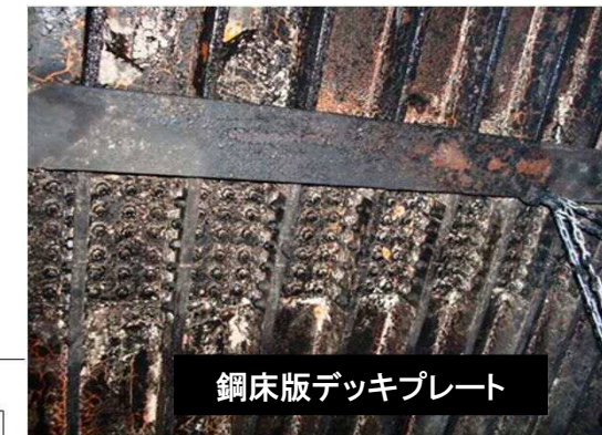
写真-3 下り線鋼床版ボルト添接部(ゆりみ無し)
