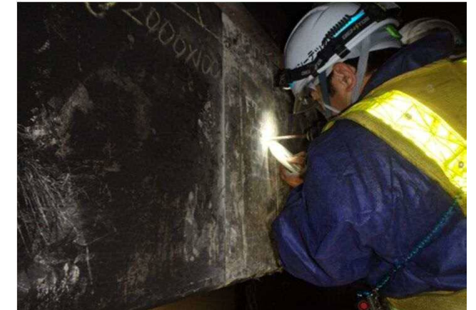
ドリル法による中性化深さ試験
