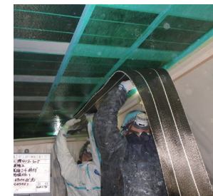
土木構造物（コンクリート床版）の補強
