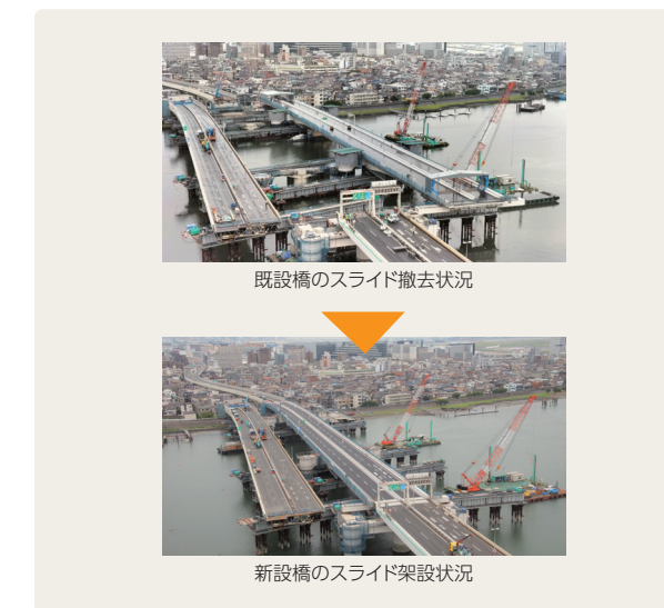
架け替えの状況 通行止めから開通までの架け替えを2週間の短期間で施工
