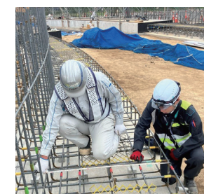
擁壁の配筋検査状況
