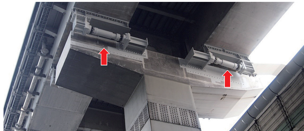
ダイス・ロッド式摩擦ダンパー
