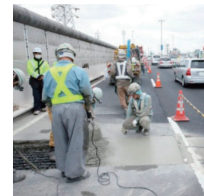
土木構造物（伸縮継手）の補修
