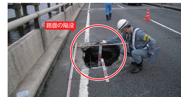
損傷状況(鮫洲埋立部)
