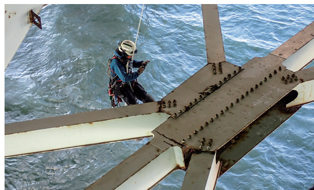
海上部でのロープを使ってアクセスする点検
