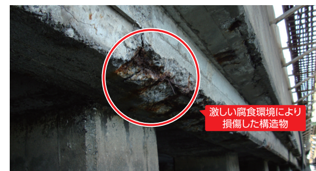
損傷状況(東品川橋)
