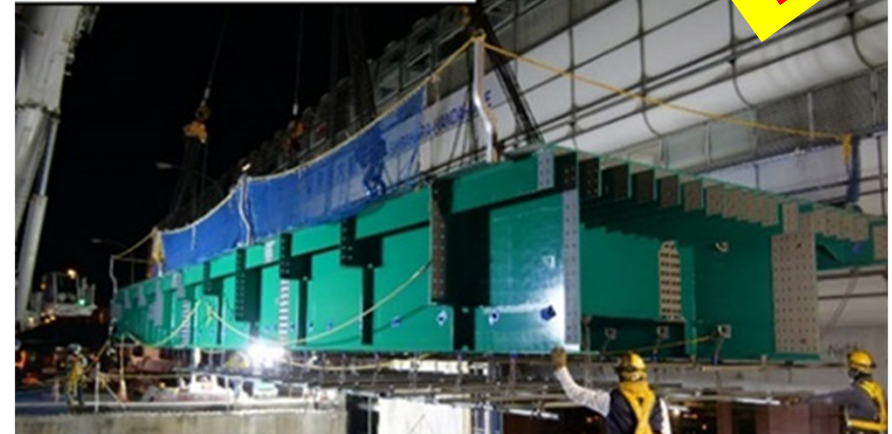
⑥新設の鋼桁の架設状況
