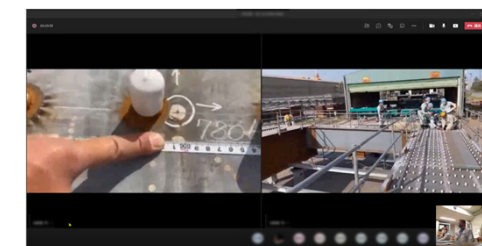
遠隔臨場の仮組立検査
