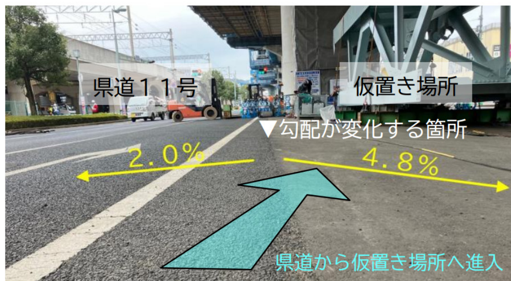
仮置き場所進入箇所の勾配状況
