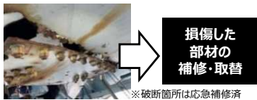
損傷部位（ガセットプレート）等の補修・取替
