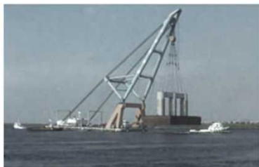
巨大な鋼鉄製の橋脚
