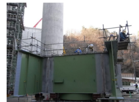
親綱設置による作業事例
