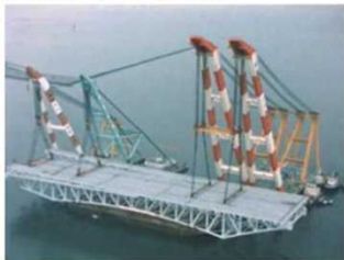
一径間分を一挙に架設
