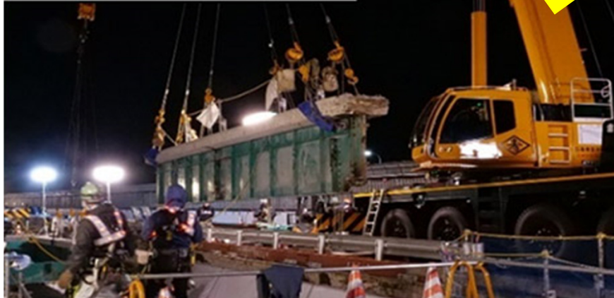
⑤既設の鋼桁の撤去状況
