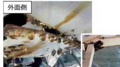
ガセットプレートの腐食・破断 ※破断箇所は応急補修済
