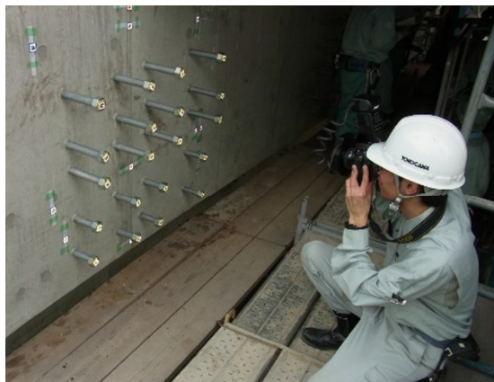
デジタルカメラによるアンカーボルトの出来形計測状況
