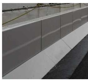
耐久性の高い塗装をした鋼製高欄へ取替
