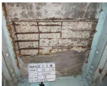
老朽化した床版（コンクリート製）約12,000 tを撤去
