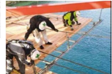
先行床施工式フロア型システム吊足場(クイック デッキ)
