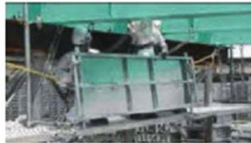
VMAXシステムを用いたパネル式吊り足場
