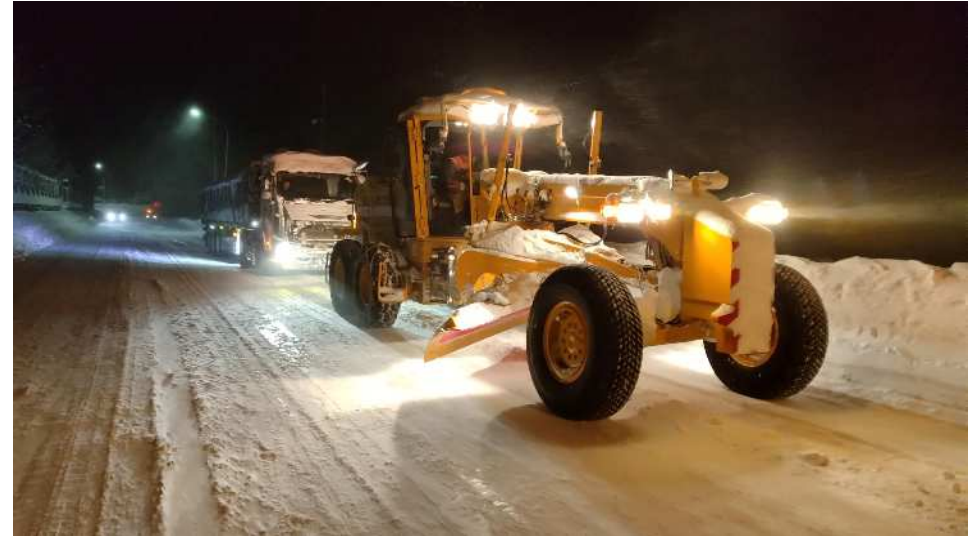
(令和6年2月 国道17号 群馬県みなかみ町)
