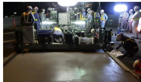
施工状況（1号上野線）
