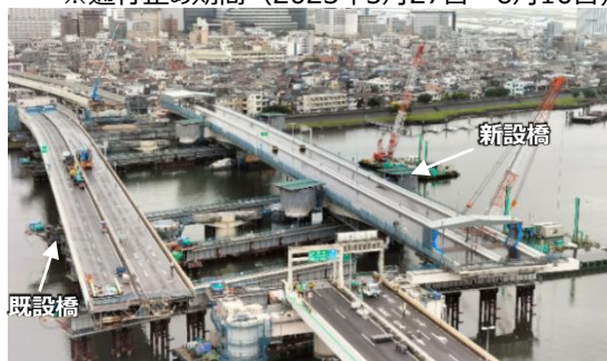
既設橋のスライド撤去状況
