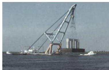
巨大な鋼鉄製の橋脚
