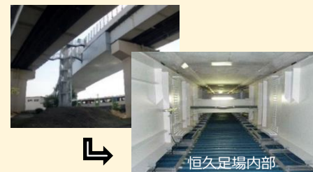
仮設足場の設置困難箇所へ設置
