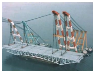
一径間分を一挙に架設
