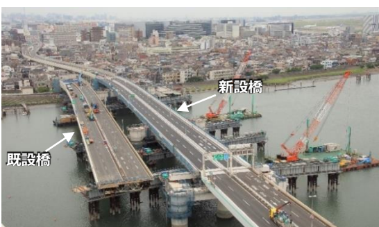
新設橋のスライド架設状況
