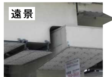
鋼桁の接続部（切欠き部）
