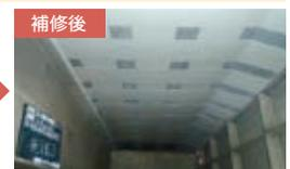
コンクリート床版の下面に炭素繊維シートを格子状に接着することで、ひび割れの開閉が拘束され、コンクリート床版の耐久性が向上します。
