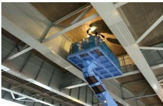
高所作業車による構造物接近点検
