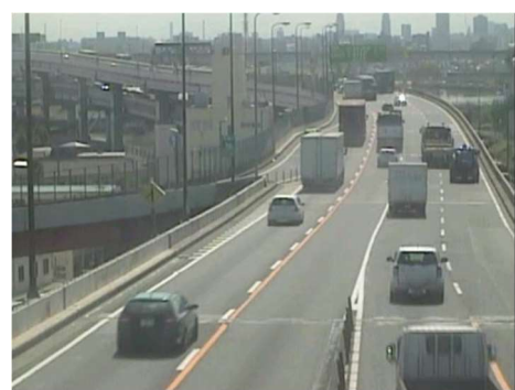
4車線化後の事例
