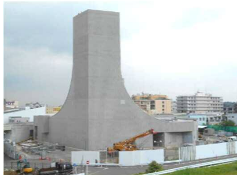
② 新横浜換気所部
