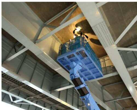
高所作業車による構造物接近点検
