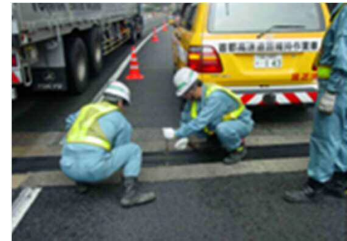
伸縮継手補修
