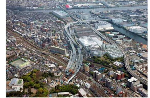
④ 生麦ジャンクション部 (全景)
