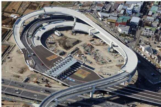
① 横浜港北ジャンクション部 (全景)
