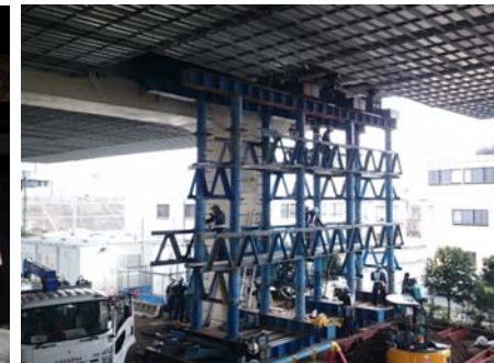
写真-4 仮支柱状況
