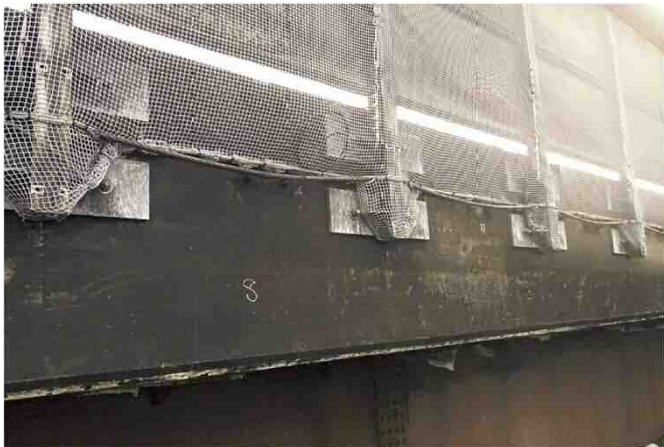
写真-6 遮音壁（落下防止ネット設置後）
