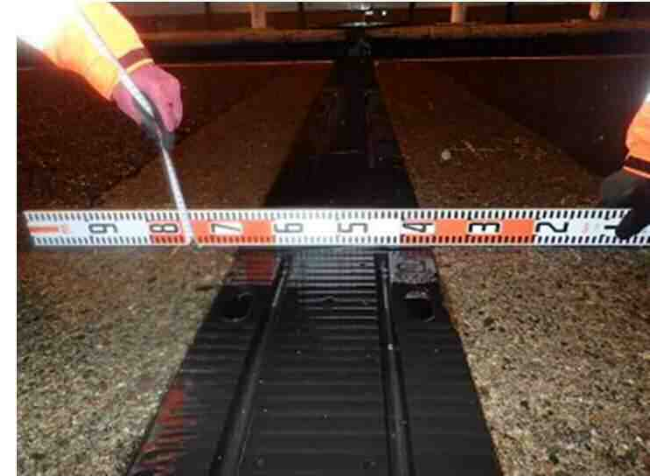
写真-5 伸縮継手
