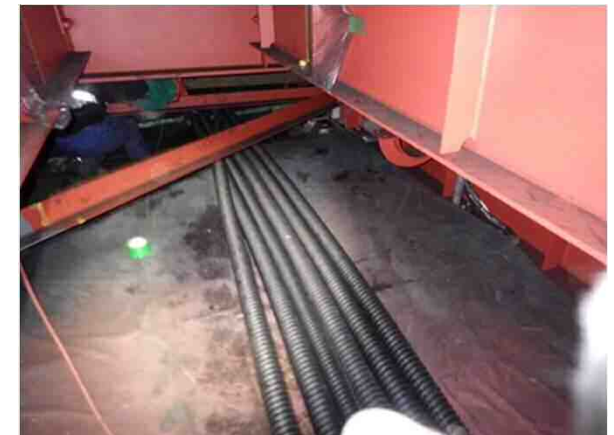
写真-8 電気ケーブルの仮復旧
