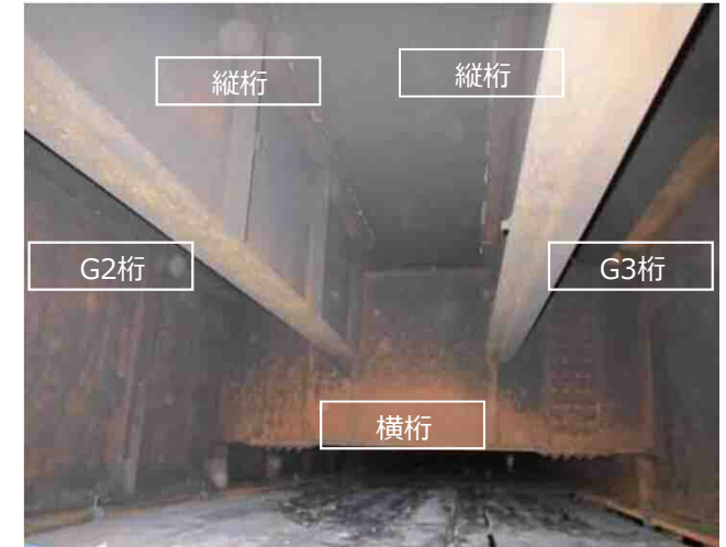
写真-9 下り線健全部の状況
