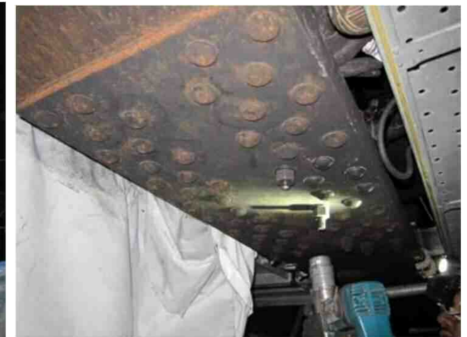
写真-12 主桁下フランジ（下り線）でのボルト交換状況
