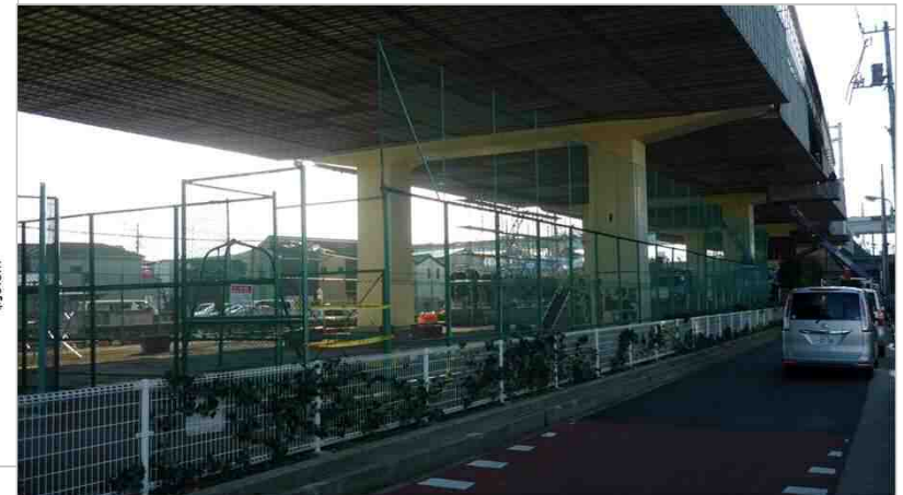
写真-3 高架下の状況
