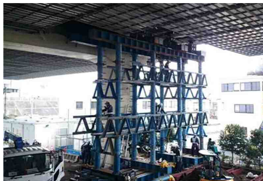
写真-1 仮支柱設置状況
