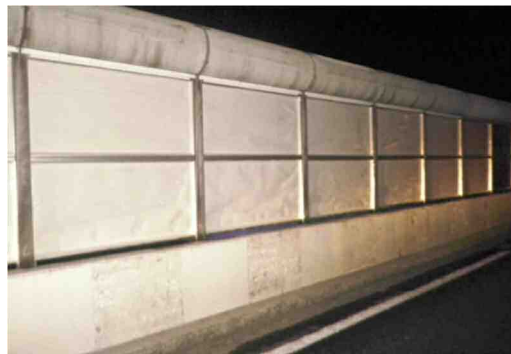
写真-2 透光板飛散防止テープ貼付
