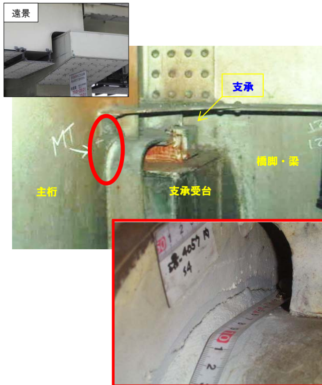
【鋼桁の接続部(切欠き部)】
