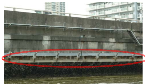
グラウンドアンカーによる補強状況
