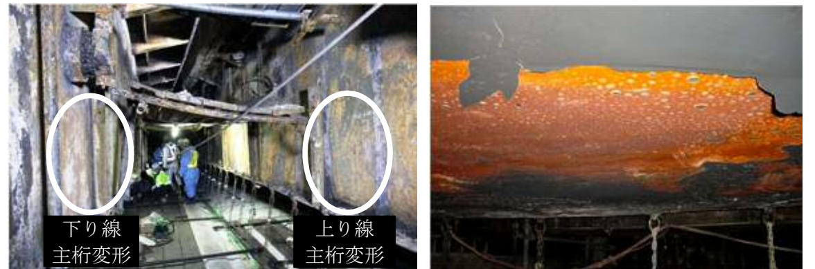
写真-1 上り線及び下り線主桁変形
