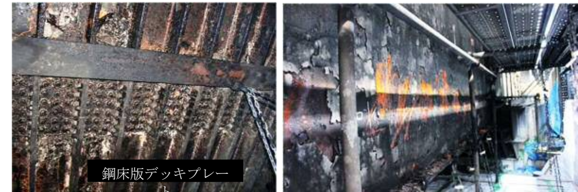
写真-3 下り線鋼床版ボルト添接部(ゆるみ無)
