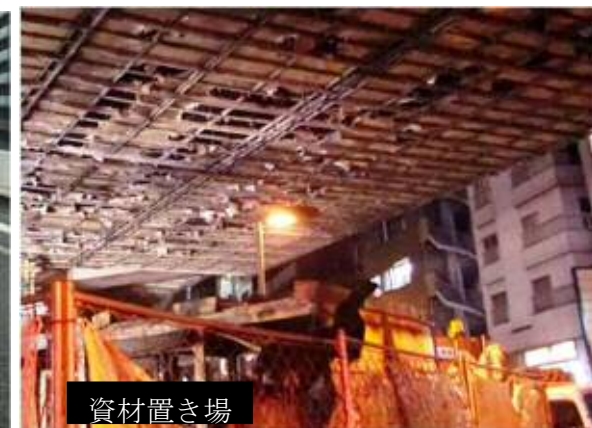
写真-6 資材置場直上 仮設足場損傷
