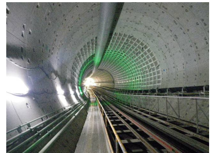
写真③ 大橋連結路シールド内 (床版工等を実施中)
