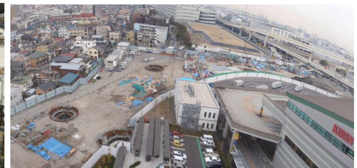
写真④ 生麦JCT (高架橋のケーソン基礎工を実施中)
