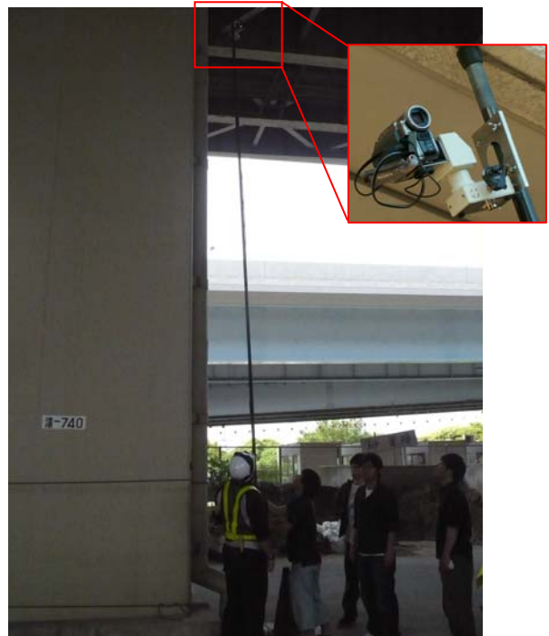
ポールカメラを用いた狭隘部の点検
