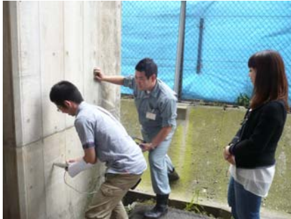
コンクリート強度測定
