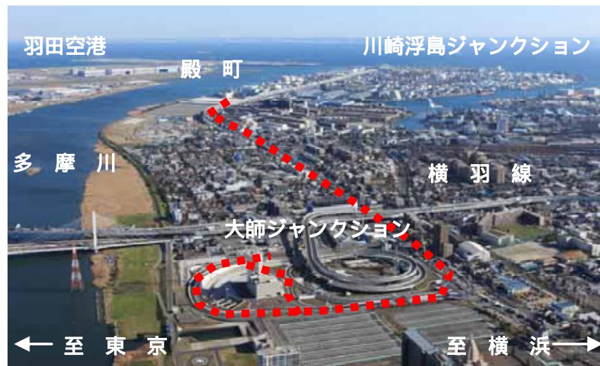
川崎線全景(殿町～大師ジャンクション)
