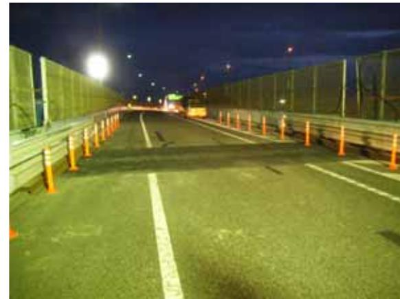
段差修正、舗装・ジョイント補修
