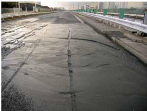
路面損傷(液状化)
