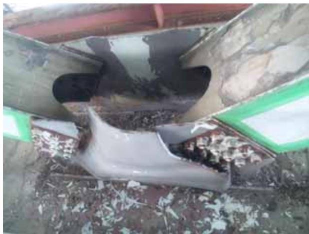
取付部材(横支材 - 対傾構)の損傷
