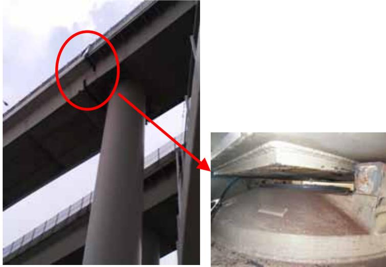
橋桁を支持する支承が脱落
