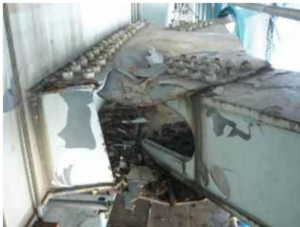
取付部材(横支材 - 下横構)の損傷
