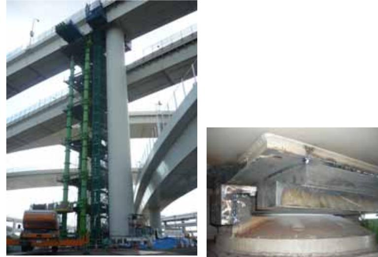
橋桁をベントで支持し、支承を補修
