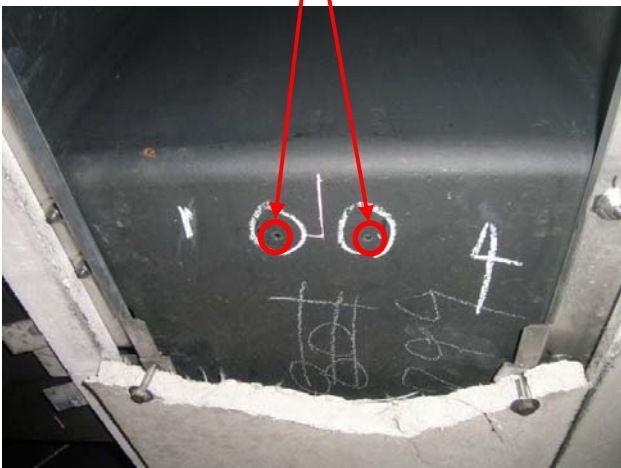
【シールドトンネル天井側取付け部】
