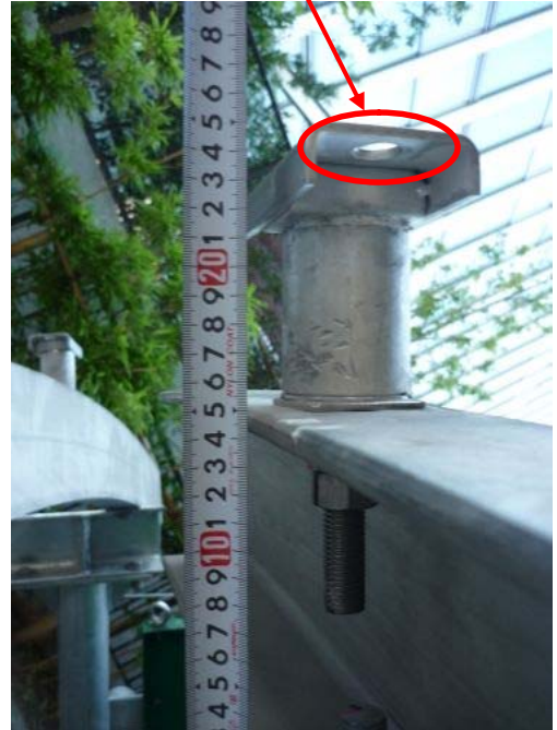
【案内看板側取付け部】
