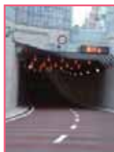
坑口フラッシング
