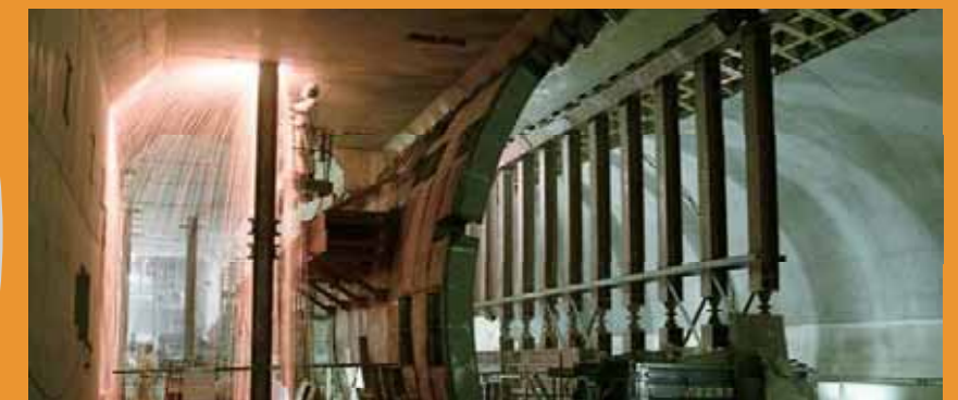
仮の柱で支えながらシールドトンネルを切り開く
