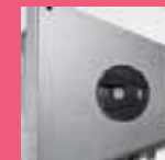
③ 火災検知器
