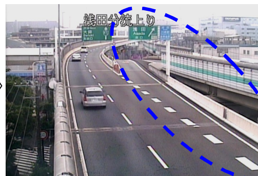
開通後(平成21年6月)
