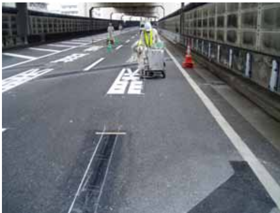
区画線工事（路面文字）
