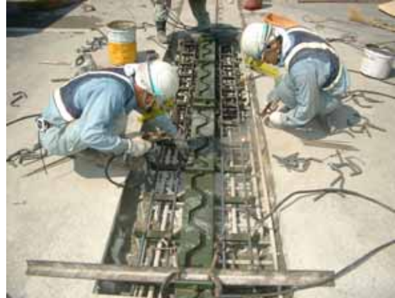
伸縮継手工事
