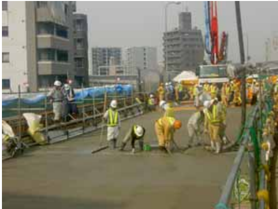
床版コンクリート打設工事
