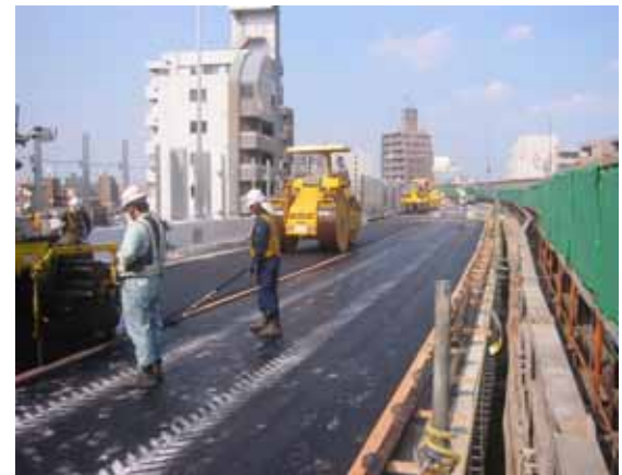
舗装打換工事
