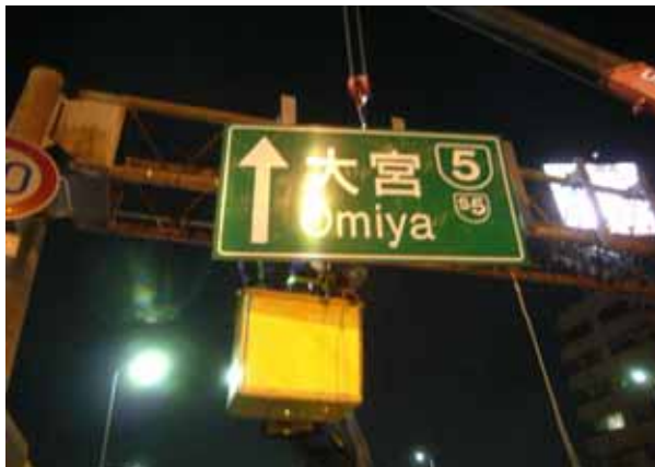
標識板撤去・設置工事
