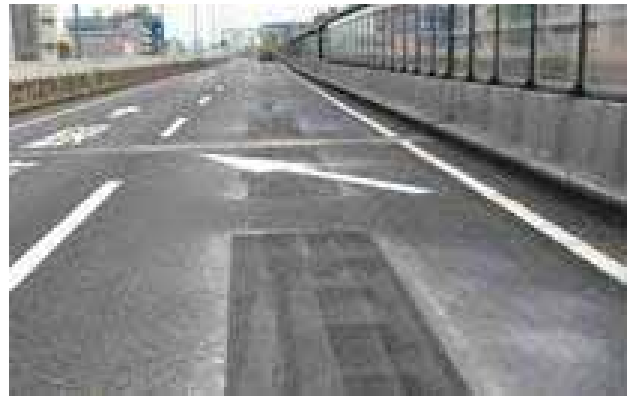
区画線消去及び新設工事
