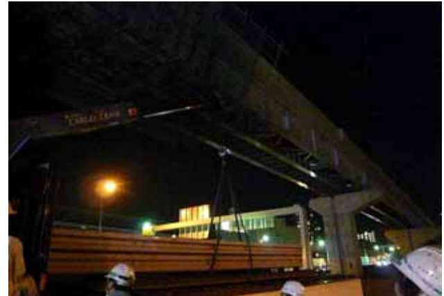
仮設ガードレール撤去・設置工事
