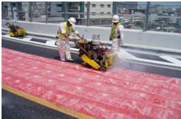
滑り止め舗装工事
