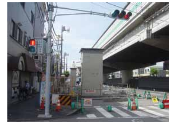
④産業道路部基礎工事
