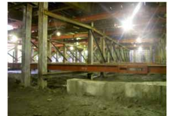
⑤開削トンネル躯体・仮設状況 (殿町)
