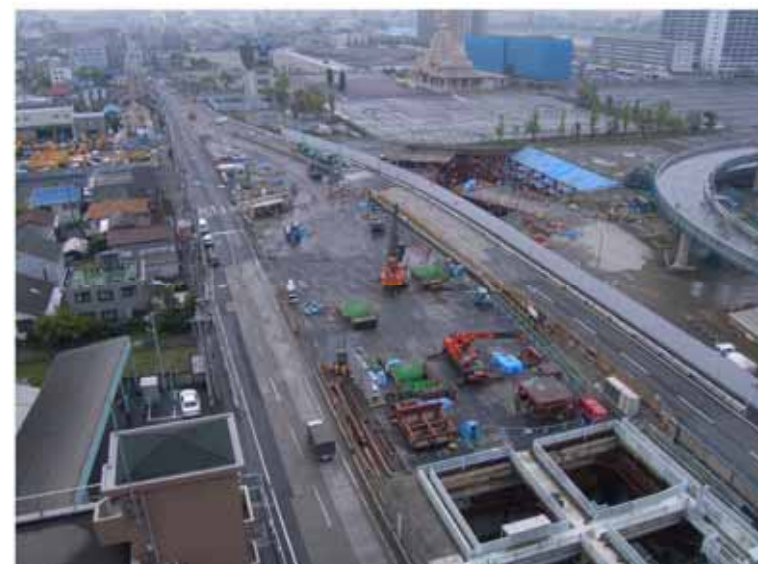
②開削トンネル覆工下での掘削・仮設 (大師)
