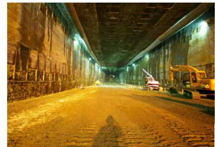
③ MMST内部掘削 (大師側)
