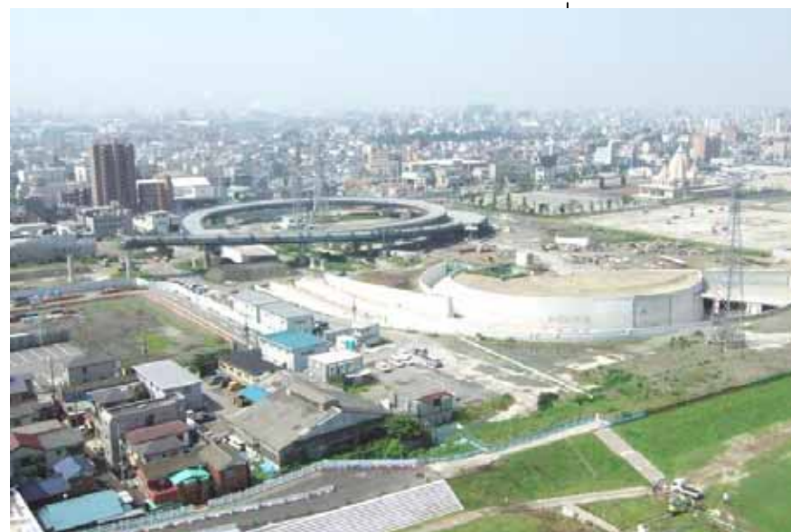
①大師JCT内全景 (施工中)
