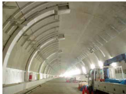
着々と進む照明・換気設備などトンネル内装工事 (西武池袋線椎名町駅付近)
