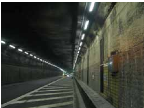
トンネル壁面 補修前
