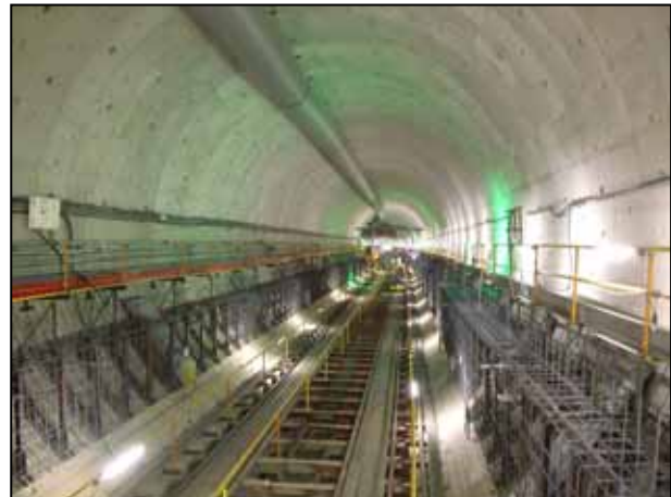
中央環状新宿線施工状況(神山・代々木シールドトンネル内)
