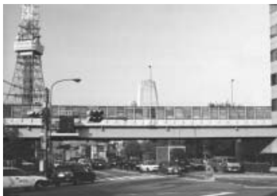
取替前（赤羽橋付近）
