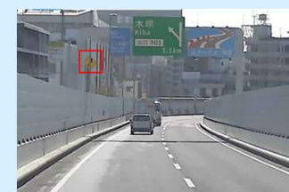
点滅式警戒標識を 超高輝度反射標識へ変更
