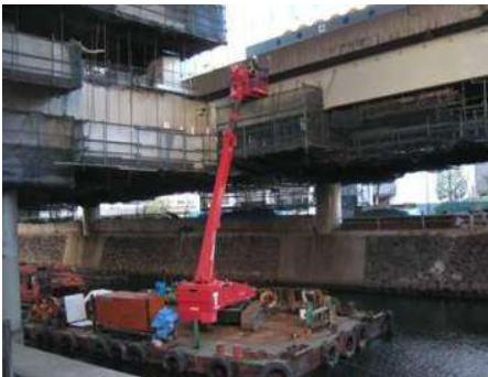
近接点検（河川上）
