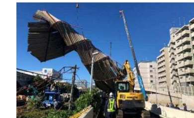
2019年台風19号によ飛来物撤去作業状況
