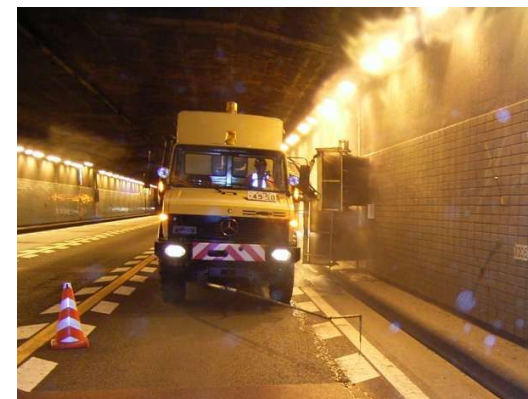
トンネル清掃
