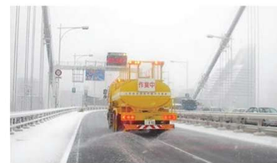
凍結防止剤散布状況
