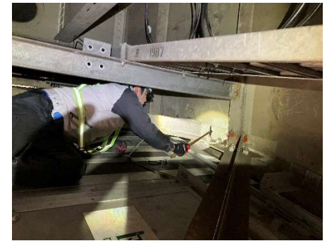
狭隘部の点検
