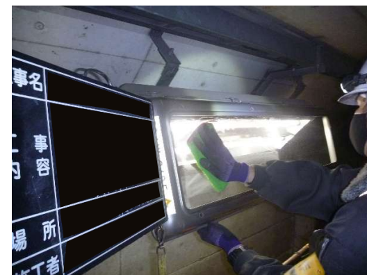
トンネル照明清掃
