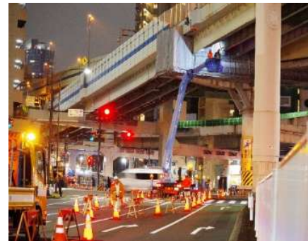
近接点検（街路上）
