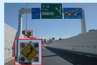
点滅式警戒標識を 超高輝度反射標識へ変更
