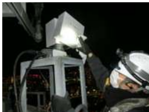
カメラ設備清掃
