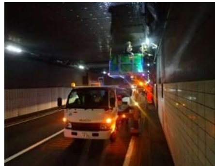
近接点検（トンネル内）
