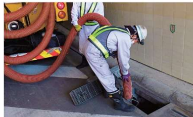
大雨前の排水柵の事前清掃
