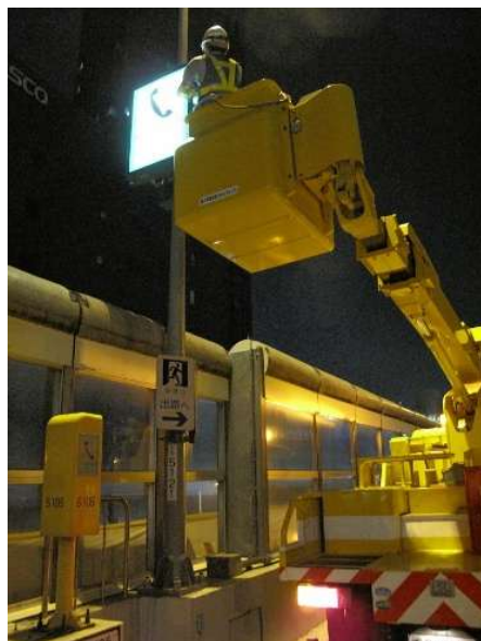
内照標識点検
