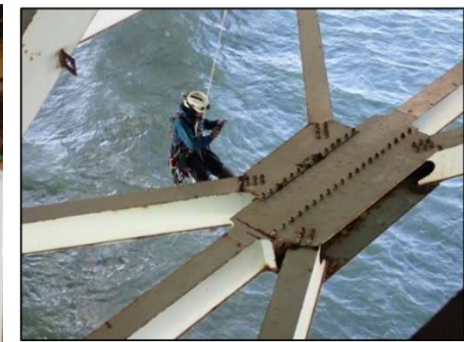
近接点検（特殊高所）
