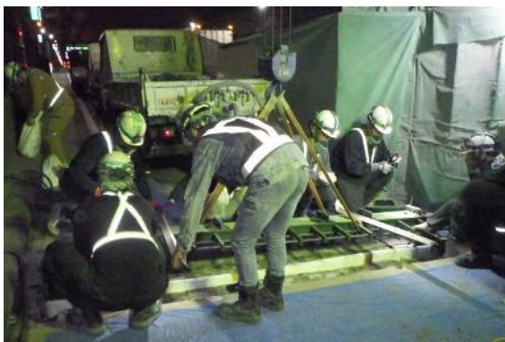
伸縮装置補修
