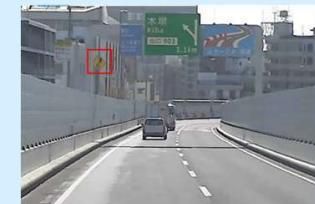
点滅式警戒標識を 超高輝度反射標識へ変更
