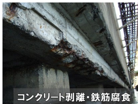
コンクリート剥離・鉄筋腐食
