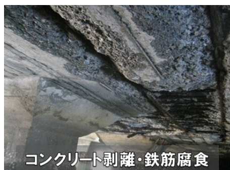
コンクリート剥離・鉄筋腐食
