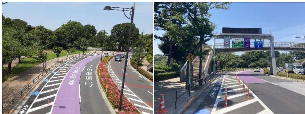
街路のカラー舗装例
