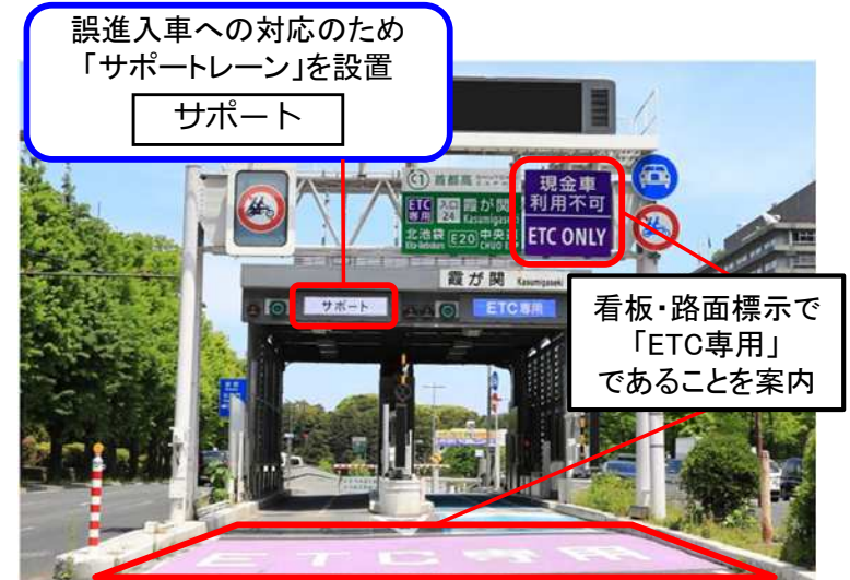
ETC専用化した首都高速道路都心環状線霞が関(外回り)入口 1
