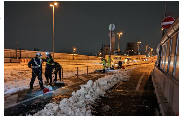
令和6年2月6日 3号渋谷線用賀付近
