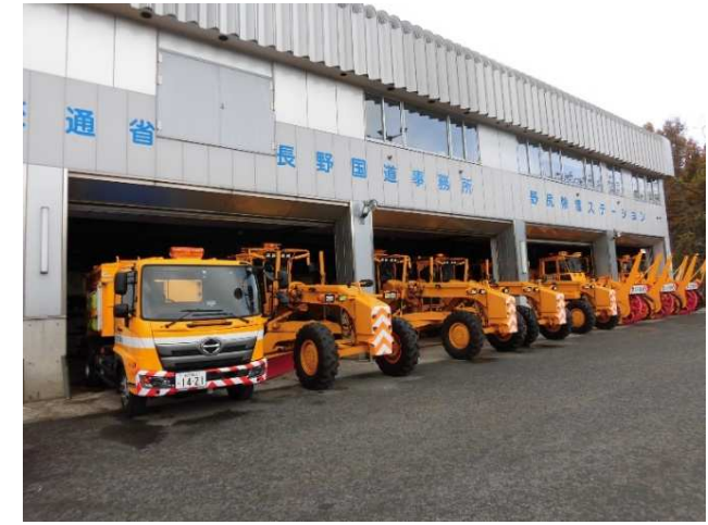
野尻除雪ステーションでの除雪機械配置状況 【長野国道事務所】
